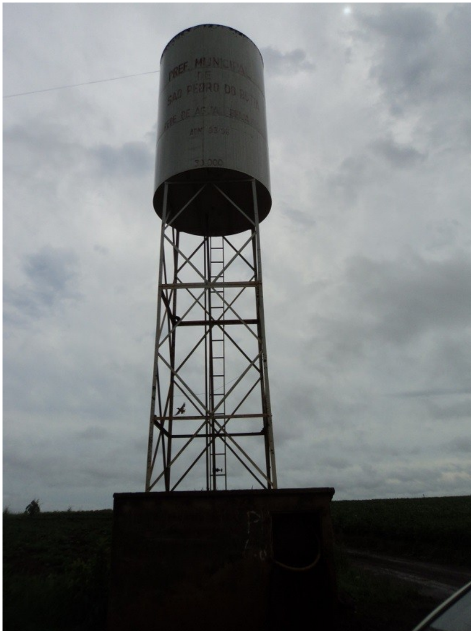
Figura 96 – Reservatório Linha Santa Terezinha
