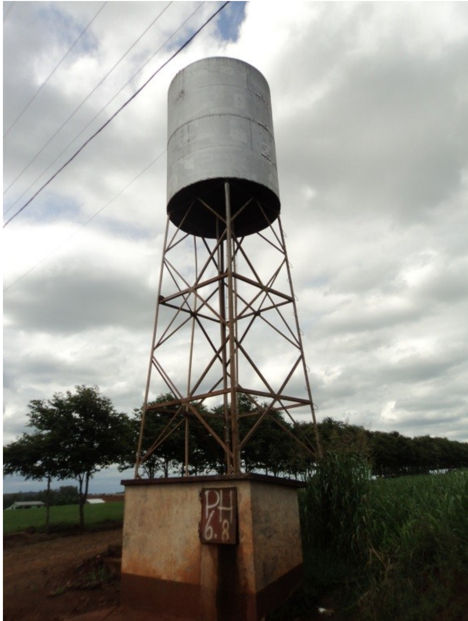
Figura 90 – Reservatório Distrito Butiá Inferior
