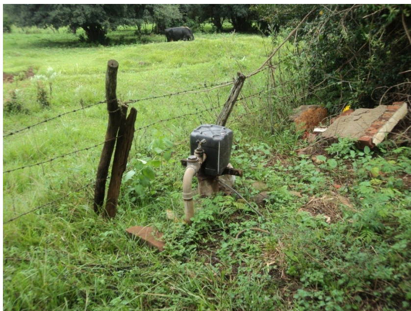
Figura 83 – Poço Taipão Fundo
