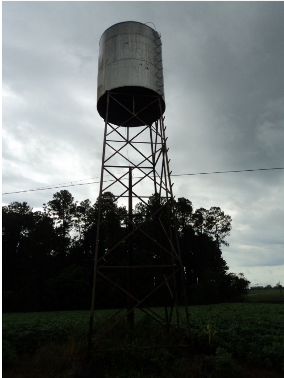
Figura 94 – Reservatório Distrito Esquina União
