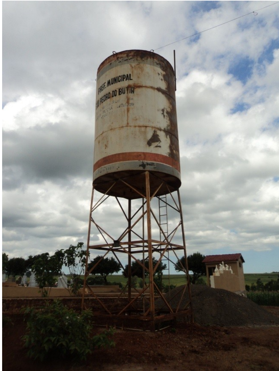
Figura 91 – Reservatório Distrito Butiá Inferior
