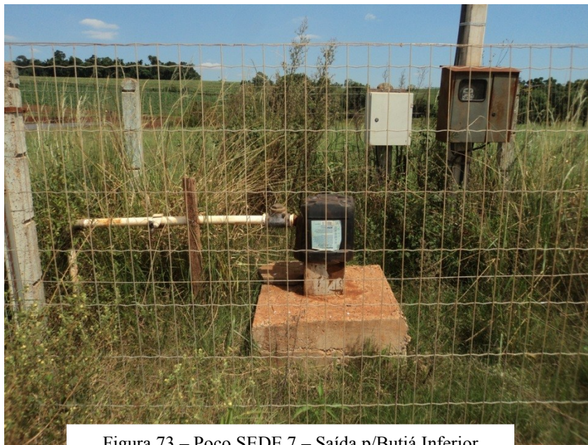
Figura 73 – Poço SEDE 7 – Saída p/Butiá Inferior
