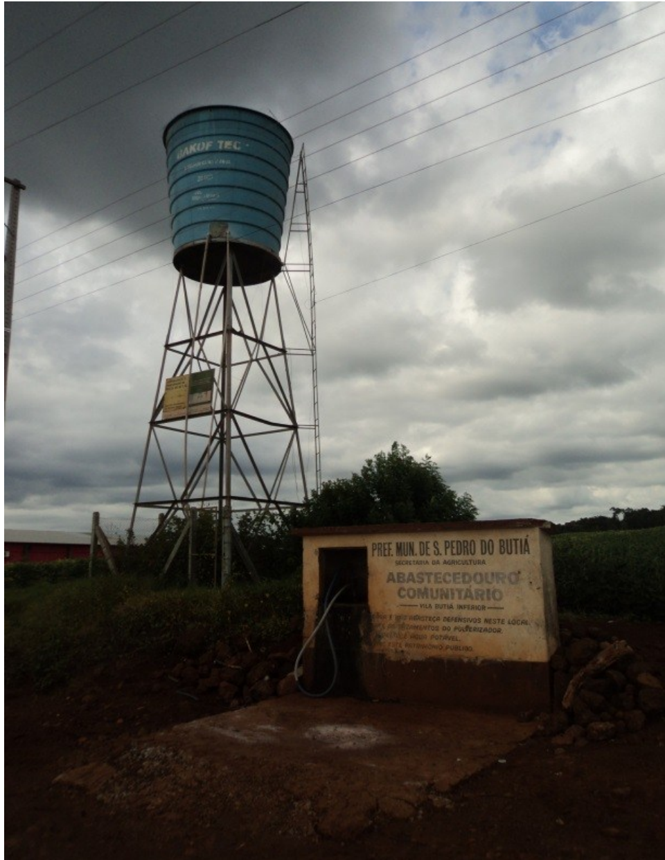
Figura 92 – Reservatório Distrito Butiá Inferior
