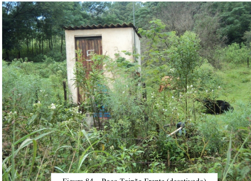
Figura 84 – Poço Taipão Frente (desativado)
