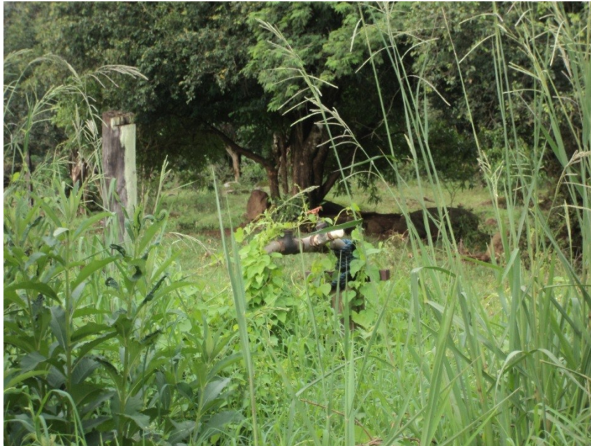
Figura 86 – Poço Linha Bonita
