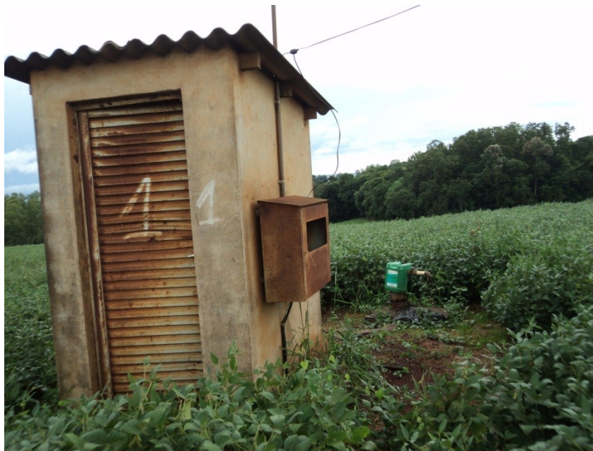
Figura 81 – Poço Santa Terezinha
