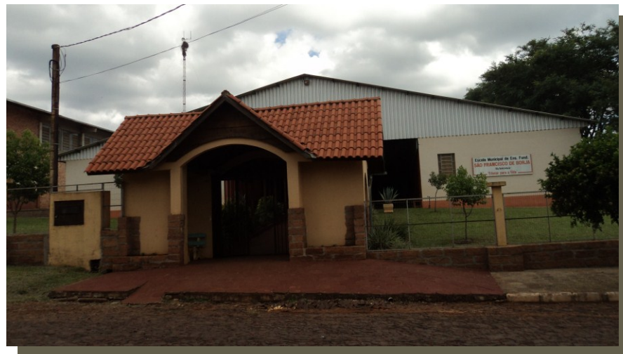
Figura 21 – Escola Municipal São Francisco de Borja
