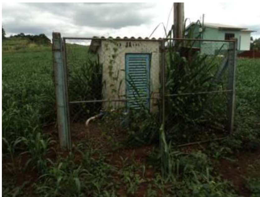
Figura 76 – Poço Butiá Inferior Norte
