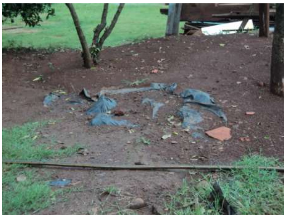
Figura 115 – Fossa Rudimentar (Poço Negro) encontrada em propriedade da zona rural
