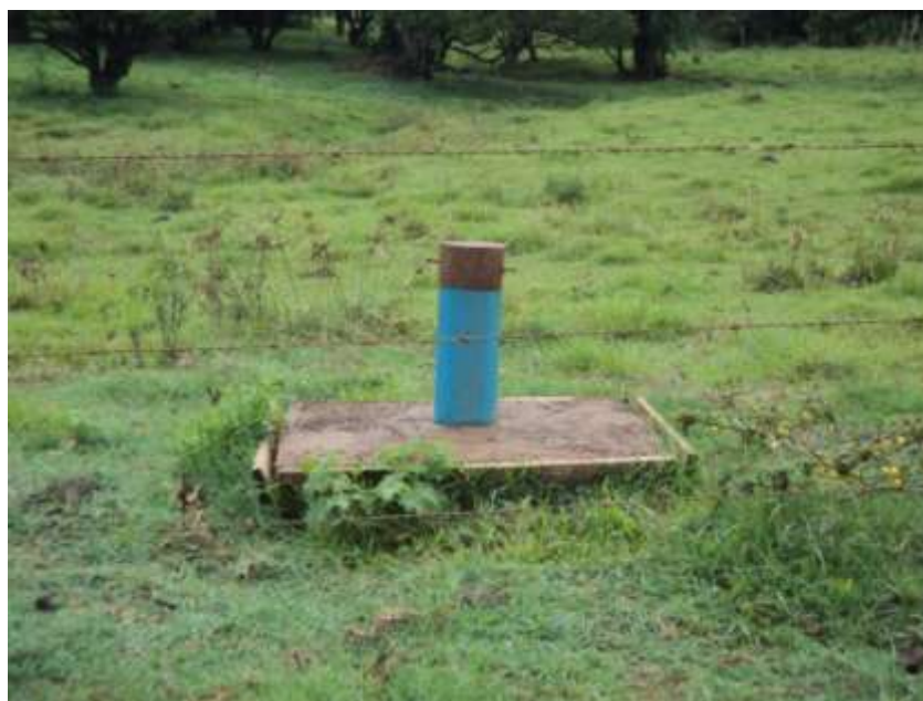
Figura 85 – Poço Taipão Frente (recém perfurado)
