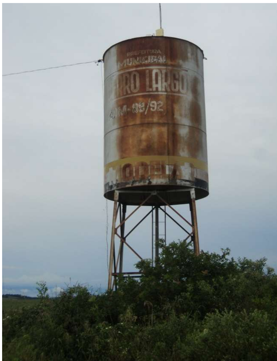
Figura 98 – Reservatório Distritos Taipão Frente e Taipão Fundo
