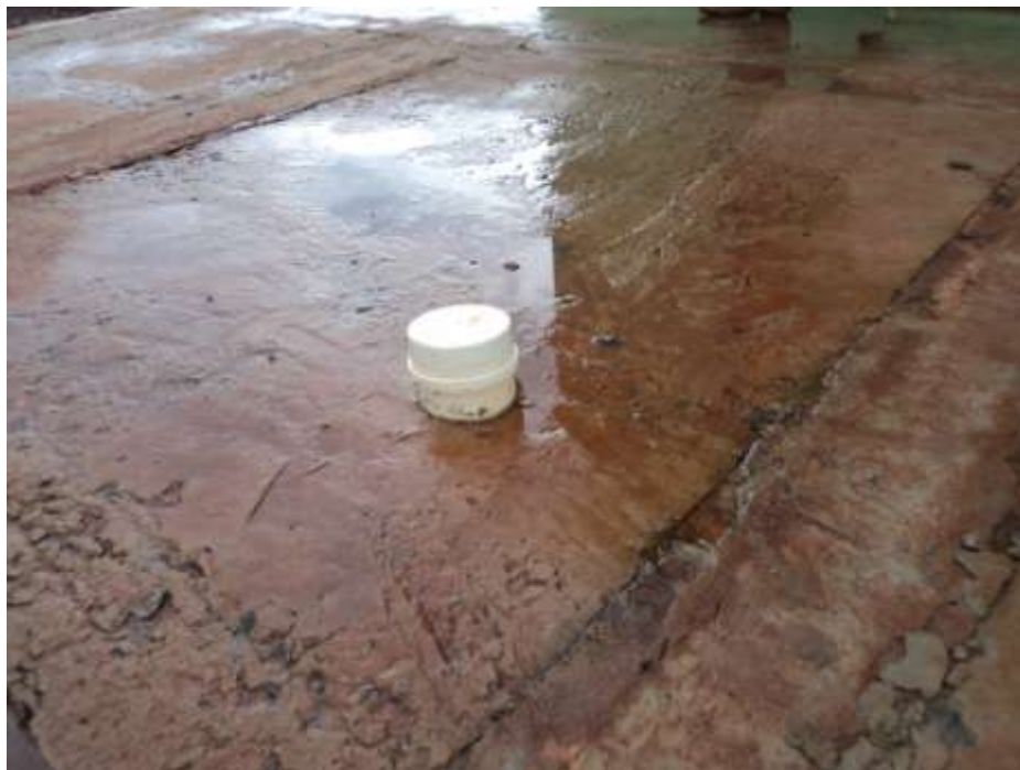
Figura 114 – Fossa Séptica encontrada no perímetro urbano
