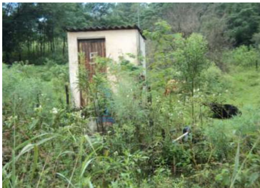
Figura 84 – Poço Taipão Frente (desativado)
