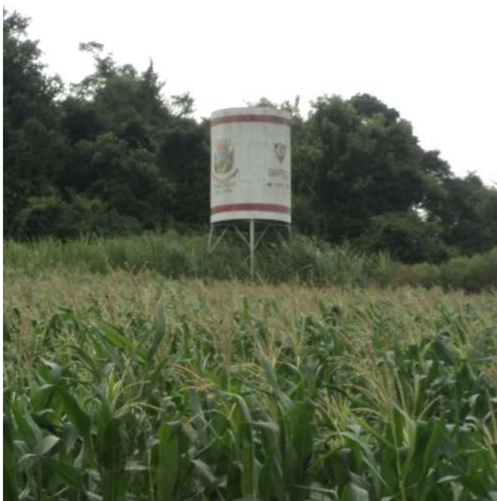
Figura 99 – Reservatório Distrito Linha Bonita
