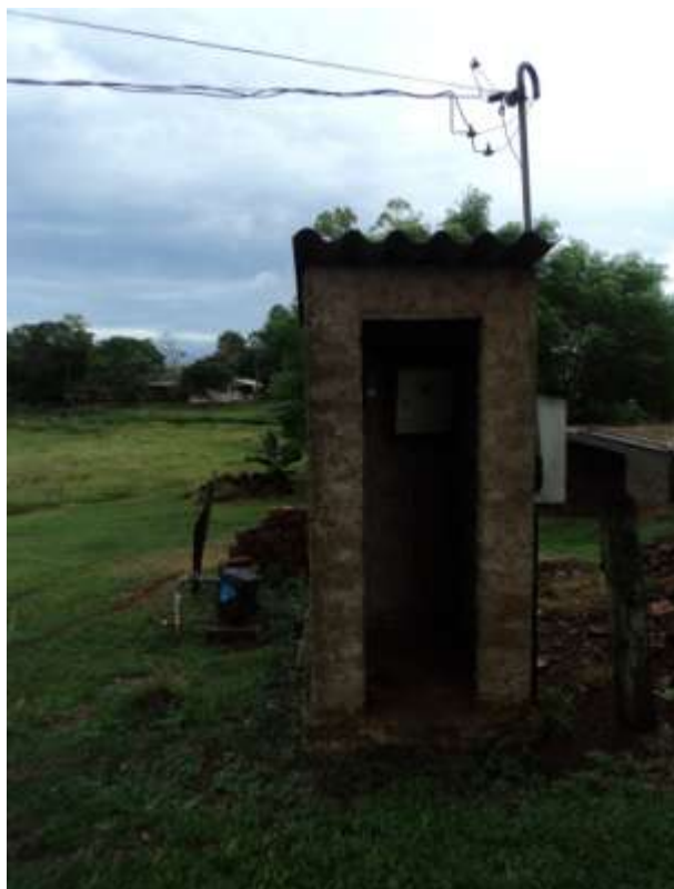
Figura 79 – Poço Esquina União
