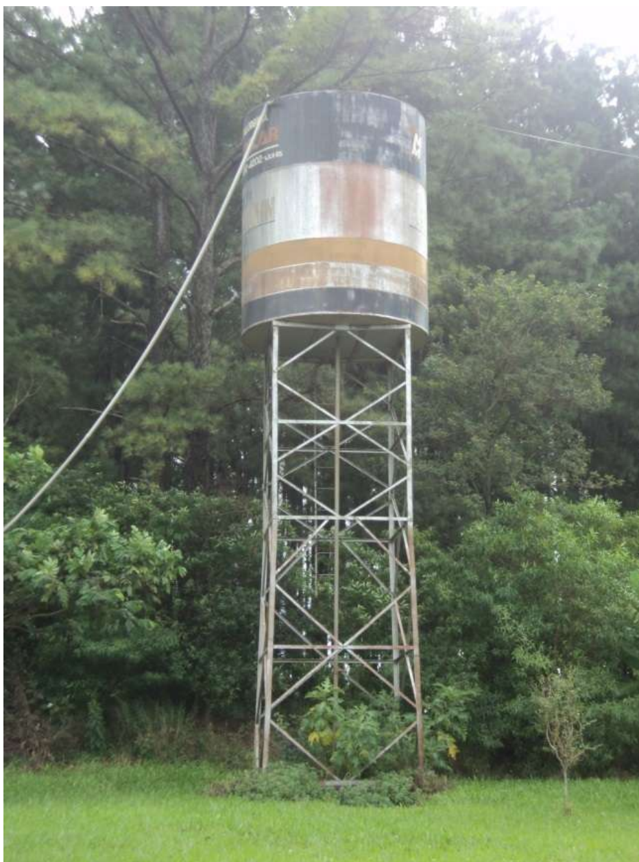
Figura 100 – Reservatório Distrito Linha Bonita Norte
