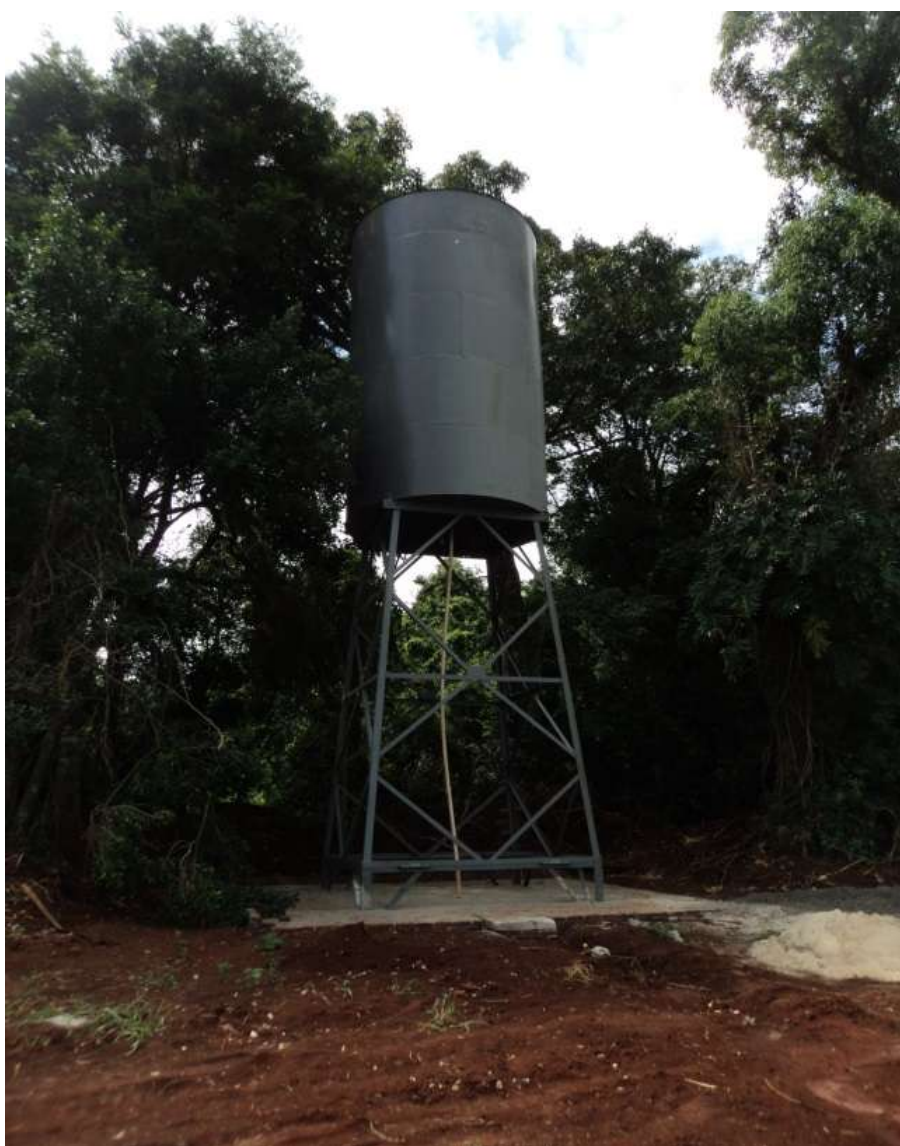
Figura 89 – Reservatório Sede II
