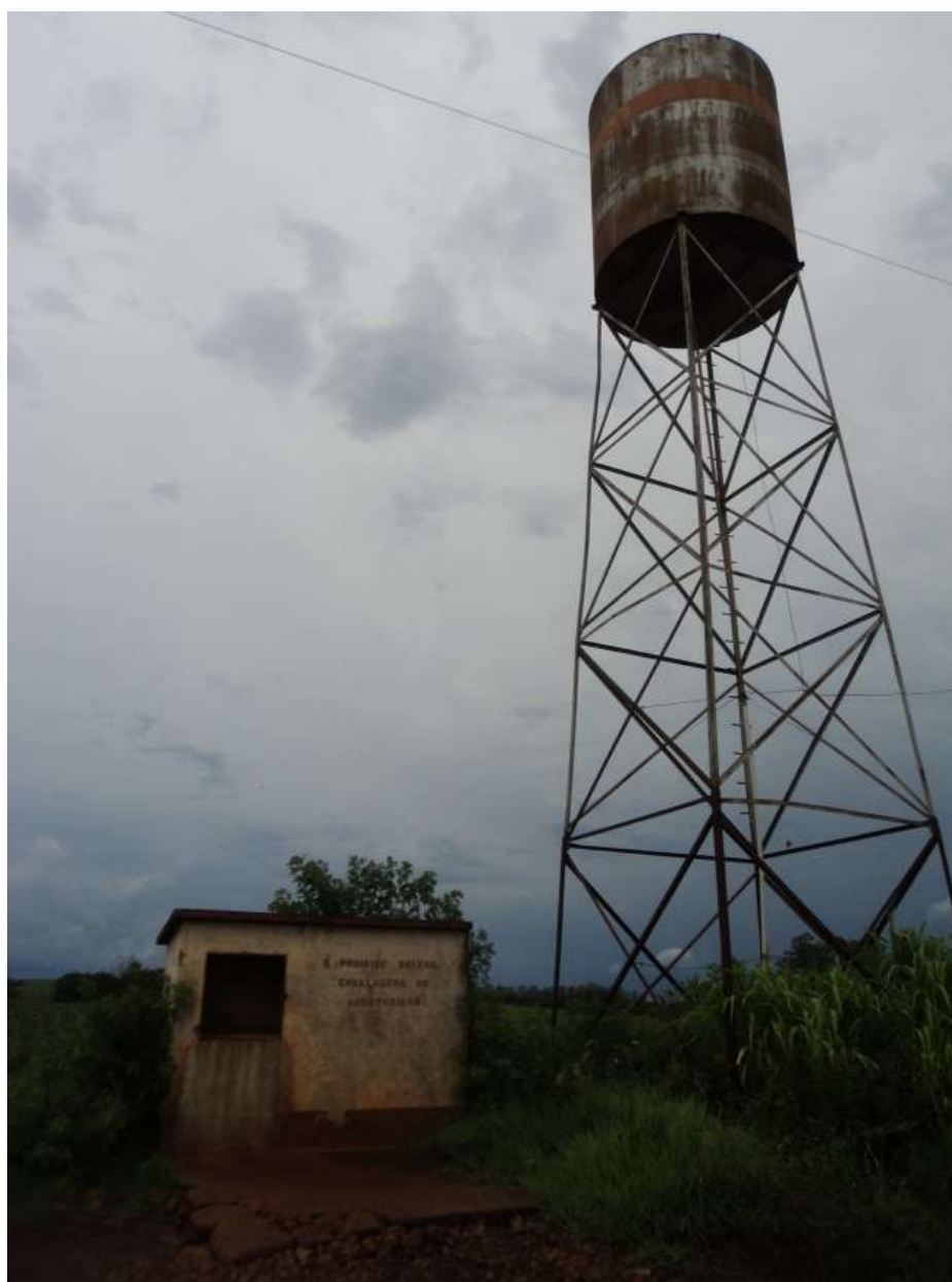
Figura 97 – Reservatório Distritos Taipão Frente e Taipão Fundo
